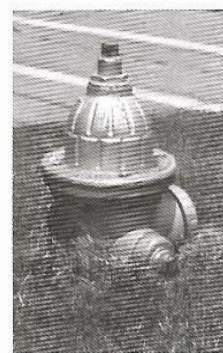
Figura 11.23 Compruebe que hay espacio suficiente entre el suelo y la salida del hidrante.
