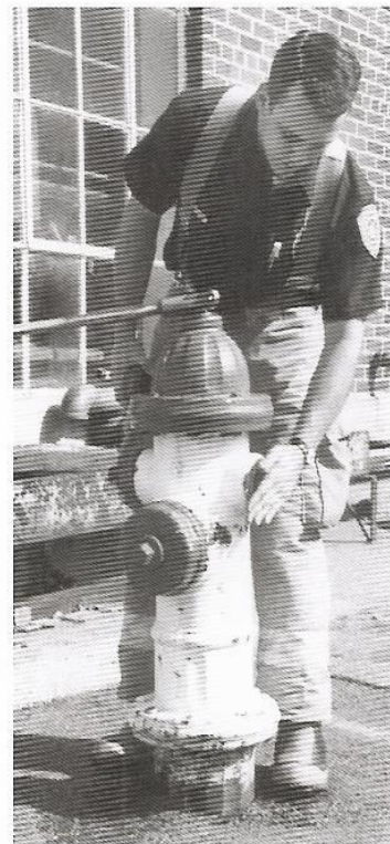
Figura 11.21 Compruebe si el hidrante está drenando.
