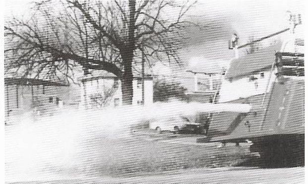
Figura 11.36 Los vaciados a chorro incrementan la velocidad de flujo de las válvulas de vaciado.
