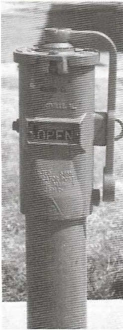
Figura 11.11 Las válvulas de seguridad muestran claramente si el abastecimiento de agua está activado o no.
