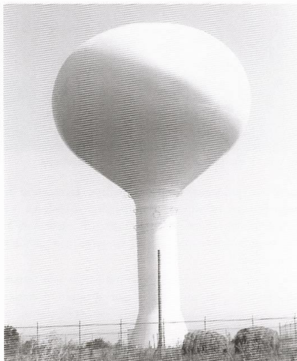
Figura 11.5 Tanque de almacenaje elevado.
