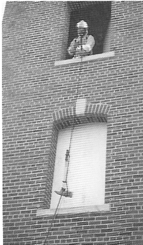
Figura 6.19 Cuerda que se utiliza para izar equipos.
