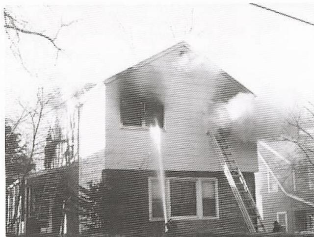
**Figura 9.57** El tejado o cualquier área del edificio debe tener al menos dos puntos con escalas. Esta planta superior tiene escalas en dos puntos. *Gentileza de Bill Tompkins.*
