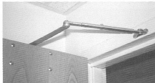
Figura 8.43 Mecanismo de autocierre de una puerta.
