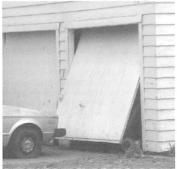
Figura 8.36 Puerta de garaje sólida. Observe que en las actuaciones de entrada forzada, puede que no se pueda abrir esta puerta a menos que no se quite el automóvil de delante de ella.
