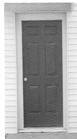
Figure 8.24 Las puertas de panel de madera están fabricadas con elementos de madera sólidos que rodean a cristal, plástico o paneles de madera.
