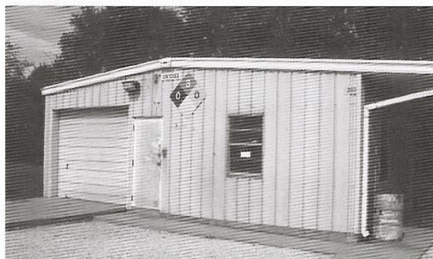
Figura 8.84 Un gran número de edificios de reciente construcción tienen muros exteriores de metal.
