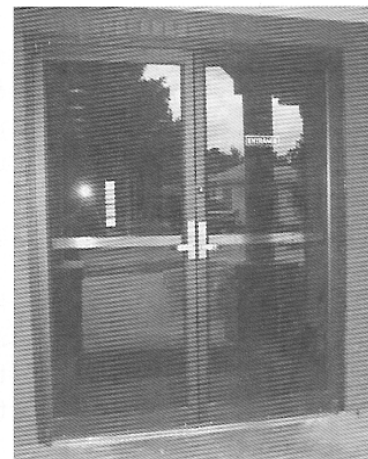
Figura 8.28 Típica puerta metálica tubular rectangular.
