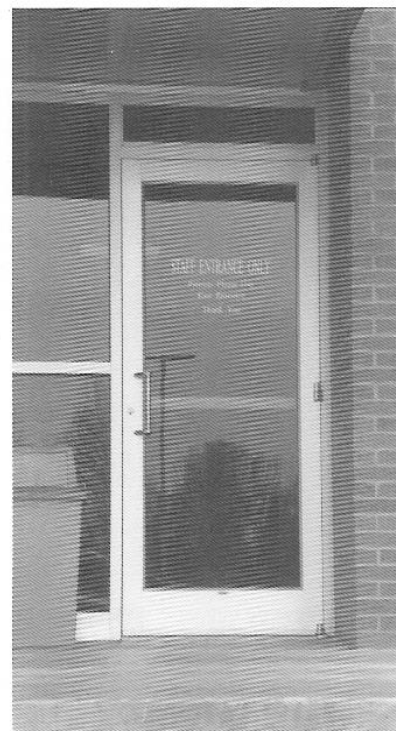
Figura 8.57 Las puertas con plafones de vidrio templado suelen tener marcos metálicos.
