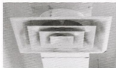
**Figura 10.15** Los conductos del aire acondicionado pueden propagar los productos de la combustión por la estructura.
