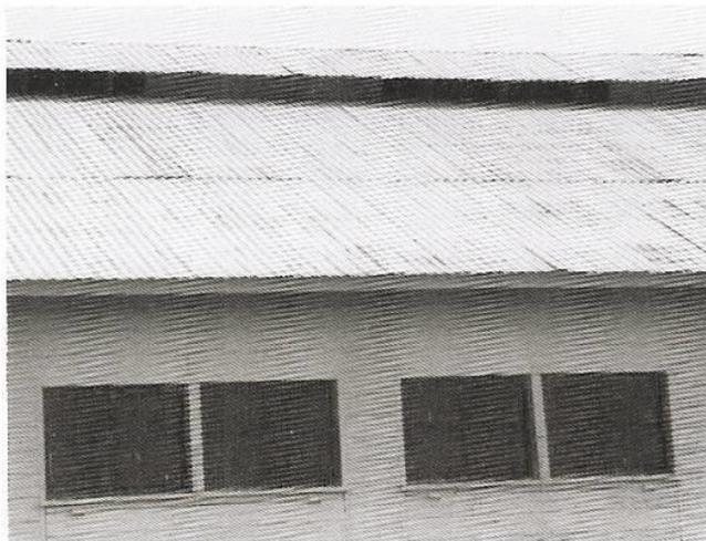
Figura 10.37 Tejado con chapa metálica ondulada.
