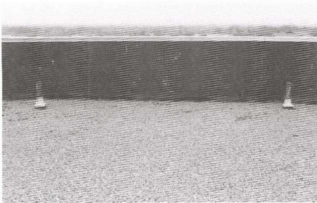
**Figura 10.32** El tejado plano suele estar traspasado por conductos de ventilación.
