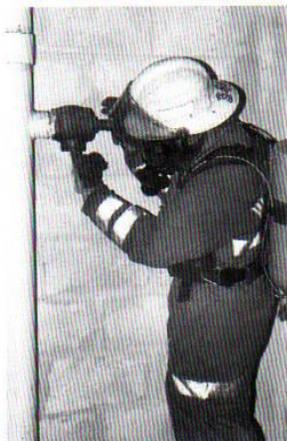
**Figura 12.85a** Compruebe la descarga para verificar que no hay suciedad.
