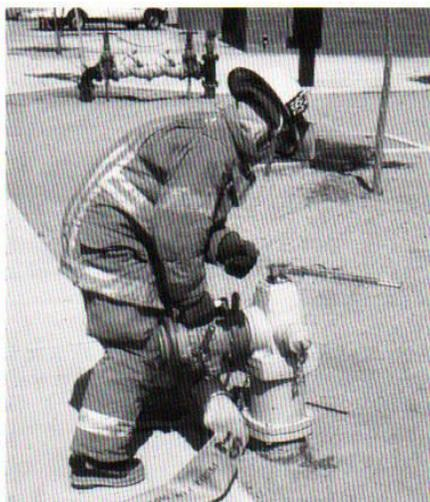
**Paso 5.** Retire la tapa del hidrante.
