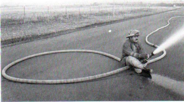
**Figura 12.94** Si se hace una gaza en una manguera de 65 mm (2,5 pulgadas), un solo bombero puede hacerla funcionar.
