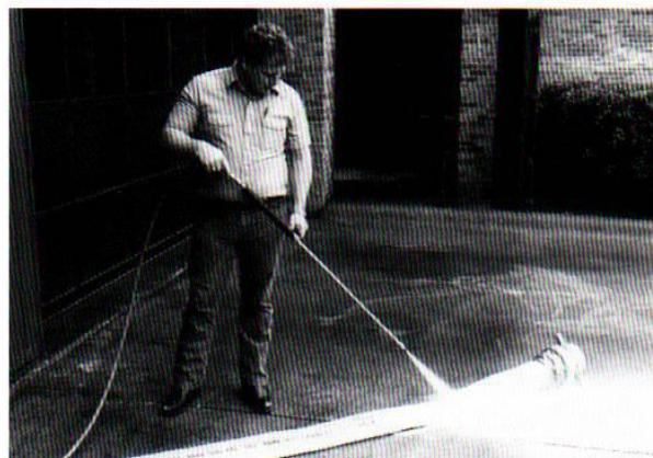
**Figura 12.11** Se puede limpiar la manguera aclarándola con agua.
