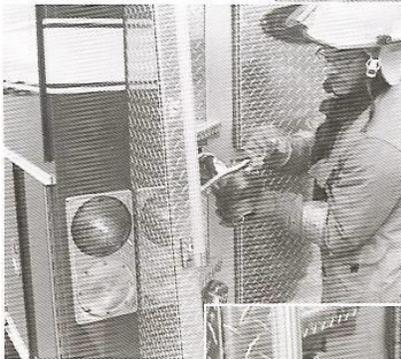
**Paso 3.** Conecte una válvula de compuerta abierta para la prueba a cada válvula de descarga.
