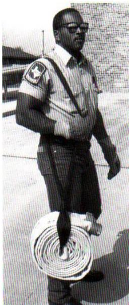
**Paso 5.** Transporte el enrollado con dos conexiones paralelas del mismo modo que si se tratase del enrollado con dos conexiones encimadas, o pase una tira corta de tela o cuerda por el rollo y átela con un nudo fácil de soltar para las actuaciones en el lugar del incendio o para almacenarlo en el vehículo.
