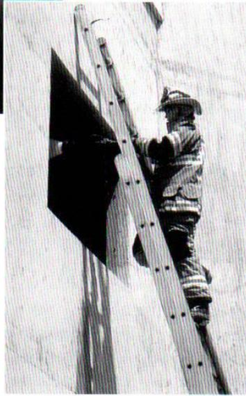
los bomberos debe estar atados a la escala mediante un seguro para la pierna o un cinturón para la escala porque se necesitan las dos manos para mover la línea cargada. Entonces, la manguera se empuja hacia arriba de bombero a bombero. El bombero que lleva la boquilla introduce la línea por la ventana y los otros bomberos siguen subiendo tanta manguera como se necesite.
