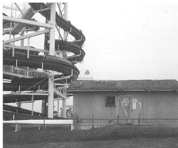
Figura 4.30 Las piscinas y los parque acuáticos pueden contener grandes cantidades de cloro en sus instalaciones.
