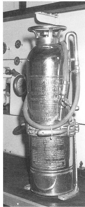
Figura 5.39 Los extintores obsoletos deben retirarse del servicio.
