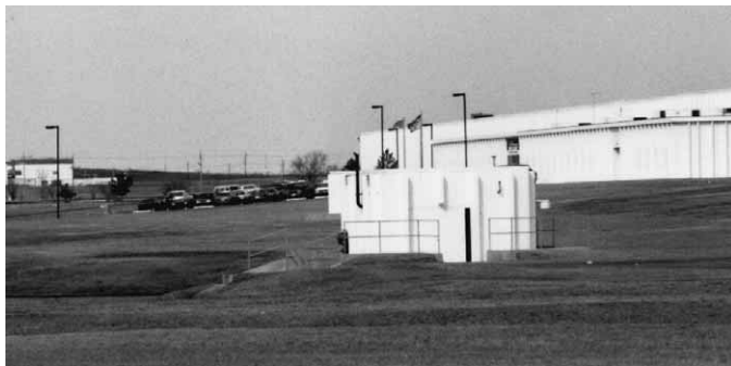
Figura 6.44 Los sistemas privados de abastecimiento de agua suelen disponer de sus propias instalaciones de bombeo.
