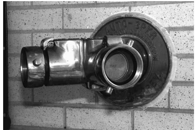
Figura 5.19 Conexión del cuerpo de bomberos.
