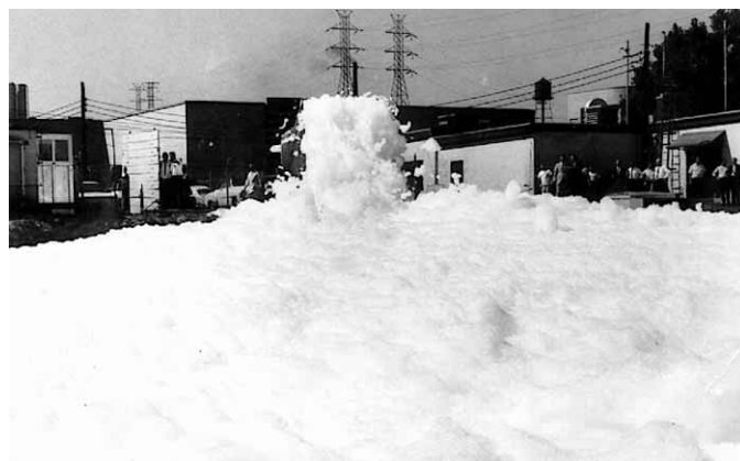
Figura 15.41 Los sopladores mecánicos generan grandes cantidades de espuma de expansión alta. Gentileza de Walter Kidde, Inc.
