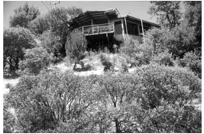
Figura 5.47 Las estructuras que están rodeadas por vegetación abundante suponen un peligro porque pueden prenderse.
