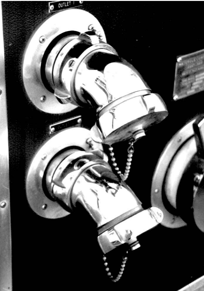
Figura 10.44 Conexión de descarga de la bomba de 65 mm (2,5 pulgadas).
