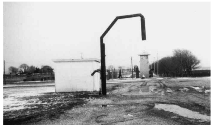
Figura 14.37 Algunas jurisdicciones disponen de torres permanentes de llenado para los camiones cisterna de carga superior.
