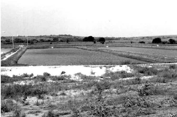
Figura 12.25 Por regla general, los depósitos en tierra se encuentran en las instalaciones para el tratamiento del agua.
