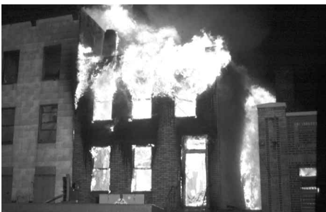
Figura 5.11 Los bomberos tienen que extremar las precauciones ante un posible derrumbamiento durante las actuaciones contraincendios. Gentileza de Harvey Eisner.
