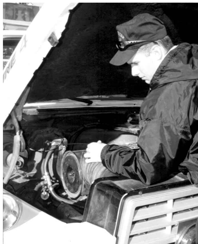
Figura 3.30 Compruebe el nivel de aceite para asegurarse de que es correcto.
