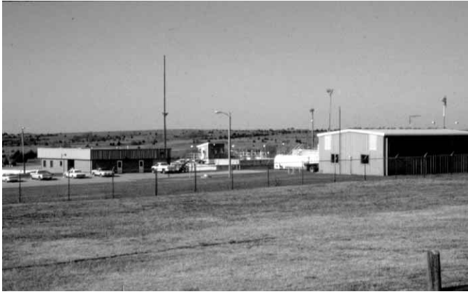
Figura 6.35 En la mayoría de los casos, las instalaciones de tratamiento de agua se encuentran adyacentes a la fuente de abastecimiento.
