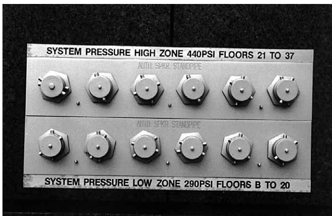
Figura 8.19c En este ejemplo, cada zona del sistema tiene una presión de toma diferente.. Gentileza de Bil Murphy.
