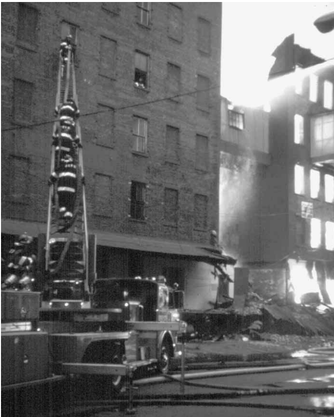
Figura 5.6 La protección de los alrededores es una prioridad en el lugar del incendio. Gentileza de Ron Jeffers.
