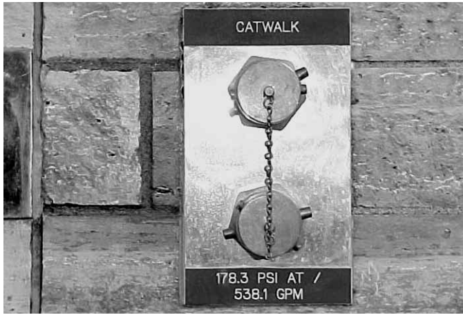
Figura 8.19a En algunas conexiones del cuerpo de bomberos se indica la presión de abastecimiento necesaria. Gentileza del City of Phoenix Department of Development Services (Departamento de servicios de infraestructuras públicas de la ciudad de Phoenix, EE.UU.).
