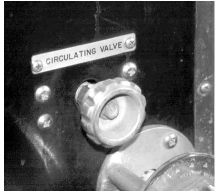
Figura 10.47 La válvula del circulador se utiliza para que la bomba no se recaliente mientras no se descarga agua.
