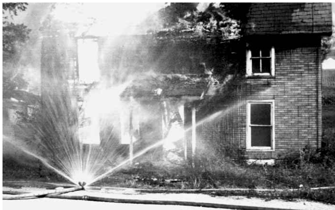
Figura 7.25 Nunca se ha llegado a demostrar que las boquillas de cortina de agua sean eficaces, por lo que en la actualidad no suelen utilizarse.
