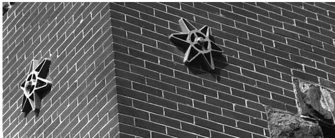
Figura 5.13 Las estrellas ornamentales indican que un edificio está en un estado deteriorado.
