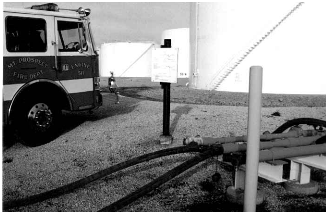
Figura 8.19b En algunos casos, las instrucciones de bombeo se encuentran en una señal adyacente a la conexión del cuerpo de bomberos. Gentileza del cuerpo de bomberos de Mount Prospect (Illinois, EE.UU.).
