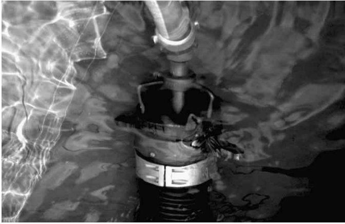
Figura 14.57a El sifón se coloca en el depósito.
