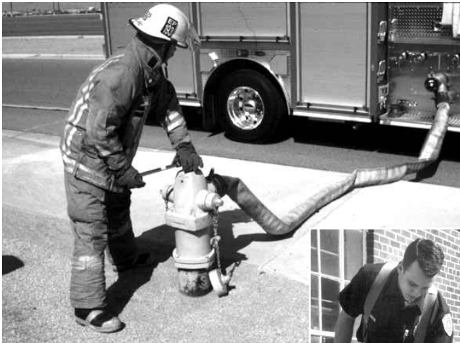
Figura 11.33 Cierre el hidrante lentamente y por completo para evitar golpes de ariete.
