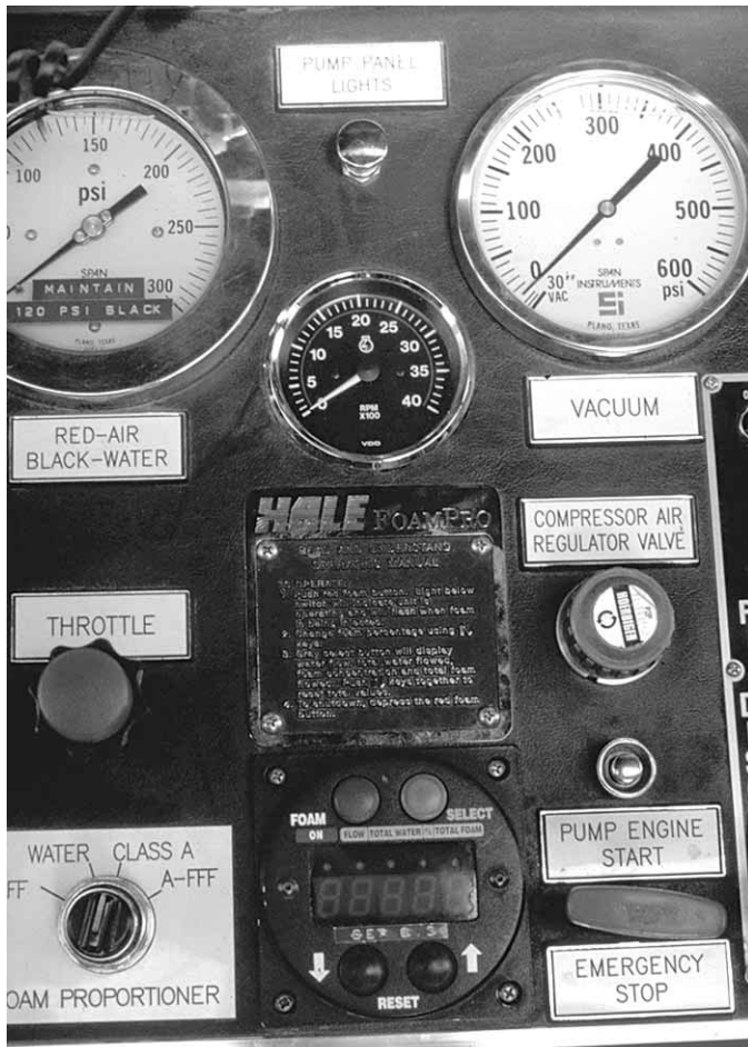
Figura 15.33 Además de los controles de dosificación de la espuma, en el panel de la bomba también están instalados los controles del aire comprimido. Gentileza del Distrito de protección contraincendios de Mount Shasta, California (EE.UU.).
