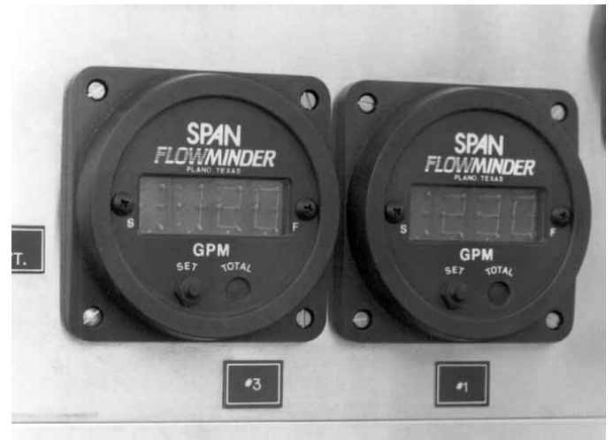
Figura 10.77 Pueden utilizarse caudalímetros en lugar de manómetros de descarga individuales.
