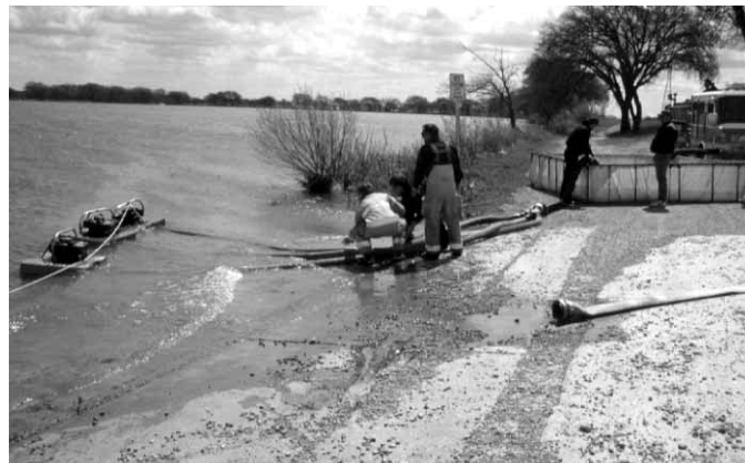
Figura 14.32 Se pueden utilizar bombas portátiles para llenar el depósito portátil, del que a su vez puede succionar agua el autobomba del lugar de llenado.
