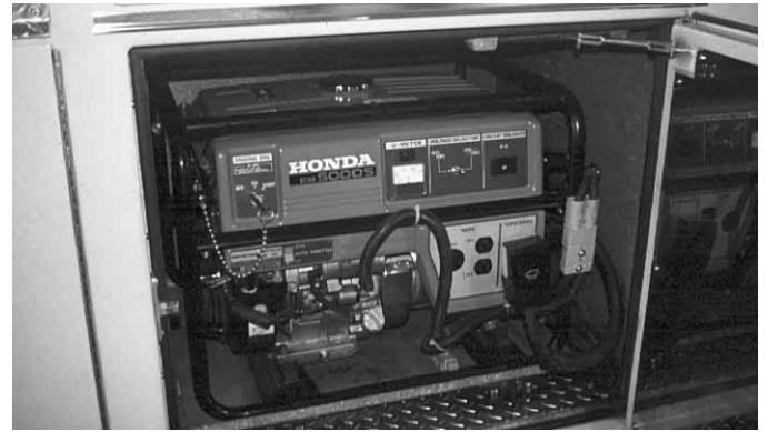
Figura 2.24 Los generadores fijos pueden proporcionar una cantidad de energía considerablemente superior a la de los generadores portátiles.
