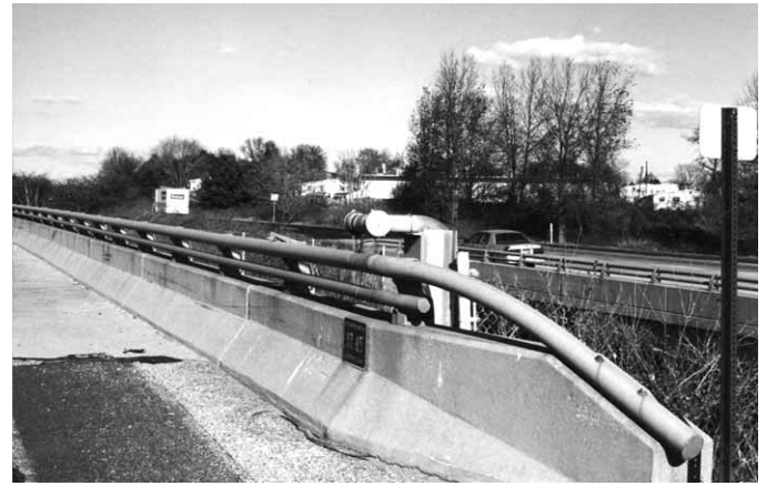
Figura 5.72 Algunos sistemas de las autopistas están equipados con sistemas de tuberías montantes secas. Gentileza de Andy Mount.
