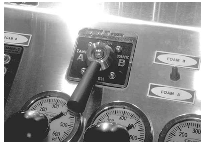
Figura 15.28 El sistema de espuma se activa mediante la válvula de cambio del sistema de espuma.
