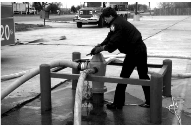
Figura 5.40 Se puede conseguir el máximo nivel de abastecimiento de agua conectando múltiples líneas de mangueras entre el hidrante y la bomba contraincendios.
