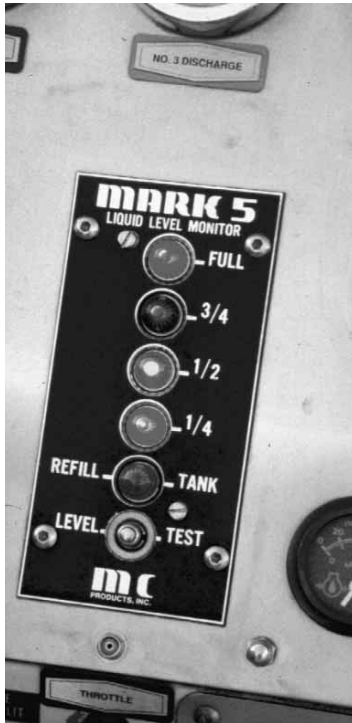
Figura 10.81a Los indicadores del nivel del depósito de agua con múltiples luces son muy habituales.
