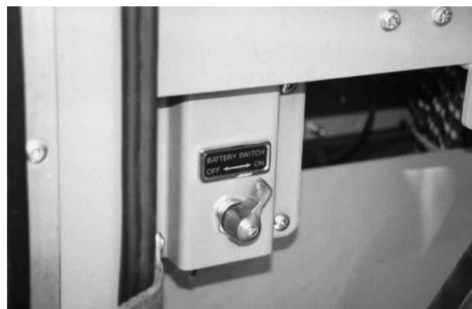
Figura 4.12 Algunos vehículos pueden estar equipados con un interruptor simple on/off para las baterías.
