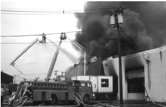
Figura 5.17 Es posible que los autobombas tengan que proporcionar agua a los vehículos con dispositivos elevadizos para sus chorros maestros elevados. Gentileza de Harvey Eisner.
