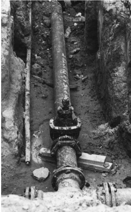
Figura 6.41 Ensamblaje típico de una válvula subterránea de abastecimiento de agua.
