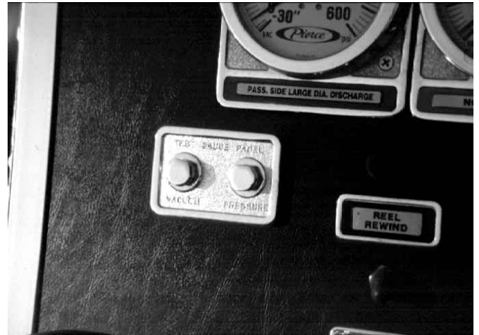
Figura 10.71 Las conexiones de prueba de los manómetros maestros de presión de toma y de descarga deben estar situados en algún punto del panel de la bomba.
