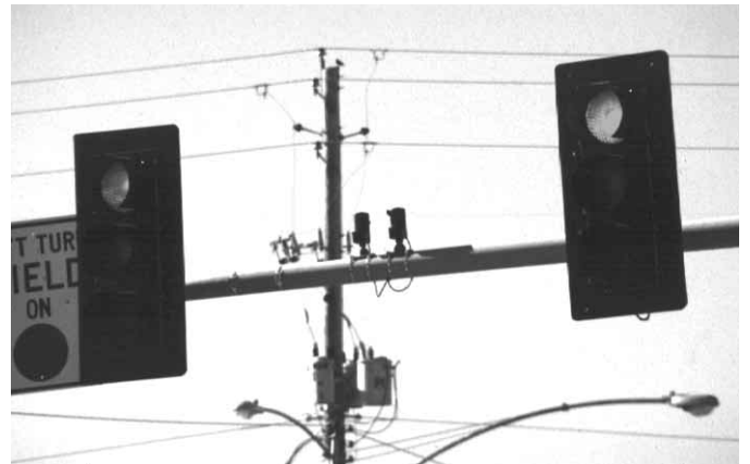
Figura 4.50 El sensor Opticom™ se coloca en algún lugar del semáforo normal.
