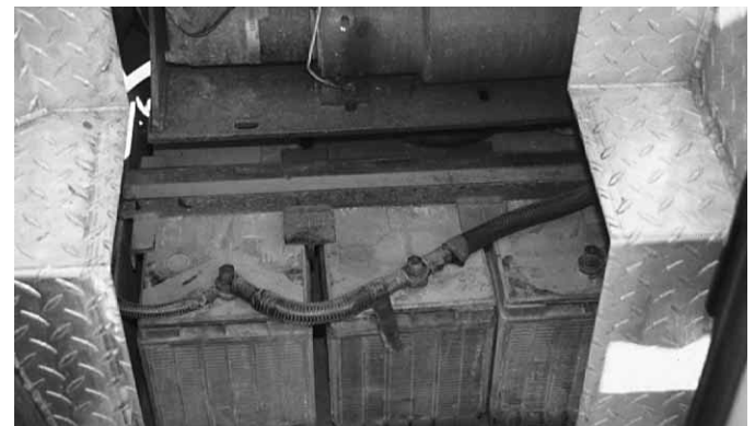
Figura 3.35b Las baterías de los vehículos a medida suelen estar situadas lejos del motor.
