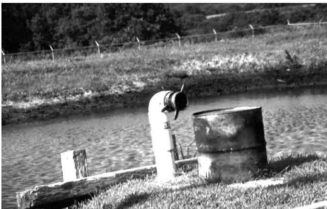
Figura 12.20 Los hidrantes para fuentes estáticas de agua aceleran las actuaciones de succión.
