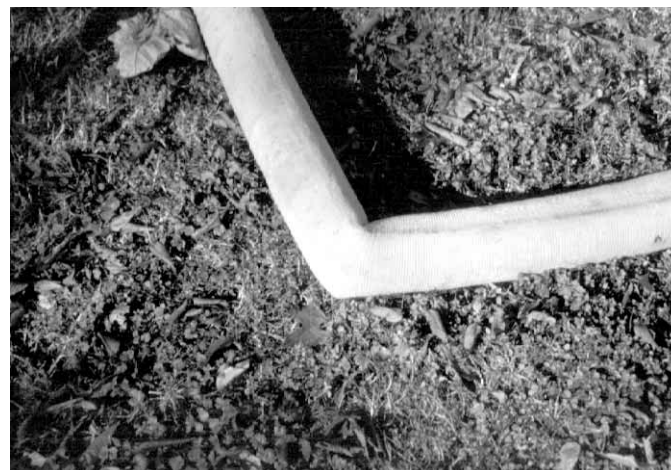
Figura 5.37 Los pliegues en la línea de mangueras pueden reducir drásticamente el flujo que entra en la bomba contraincendios.
