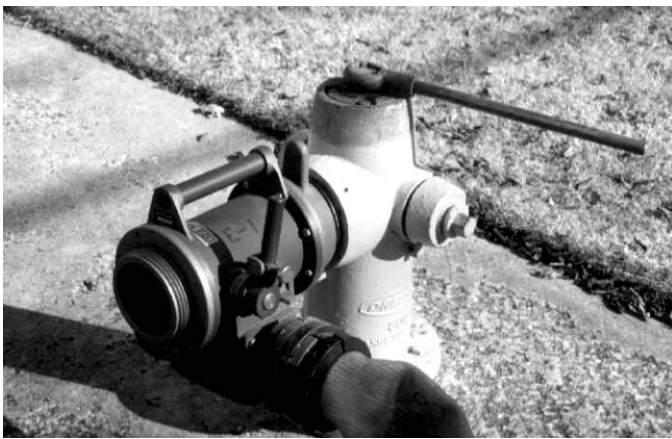
Figura 11.21 Las válvulas del hidrante suelen utilizarse en los cuerpos de bomberos que realizan normalmente tendidos hacia el incendio.
