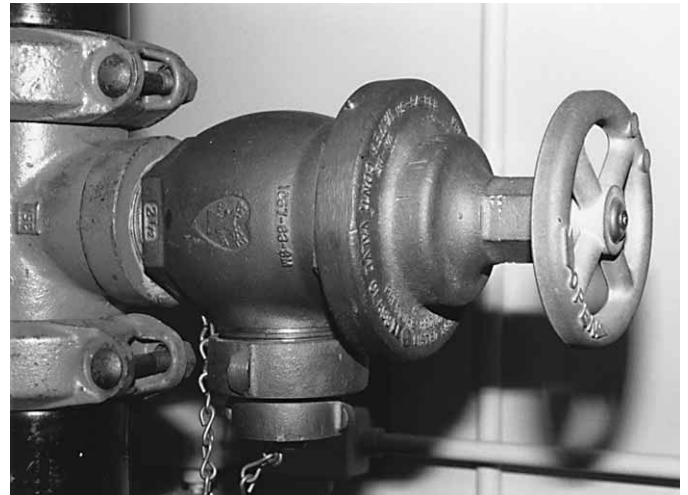
Figura 11.65 Las válvulas reductoras de la presión suelen utilizarse en edificios altos.
