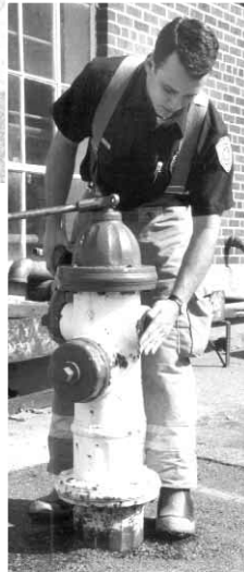
Figura 11.33 Cierre el hidrante lentamente y por completo para evitar golpes de ariete.
