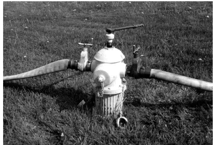
Figura 11.26 Algunas jurisdicciones necesitan conectar una válvula de compuerta a la descarga del hidrante no utilizada. Gracias a ello, se puede llenar una segunda línea posteriormente sin cerrar el hidrante. Gentileza de Rich Mahaney.
