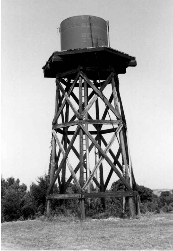
Figura 12.24 Algunas propiedades privadas poseen pequeños depósitos de agua elevados. Este depósito no puede proporcionar suficiente agua para una actuación contra incendios prolongada.
