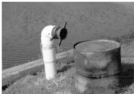
Figura 5.28 Las jurisdicciones que disponen de una fuente de agua estática suelen instalar hidrantes para fuentes de agua estática en lugares clave.
