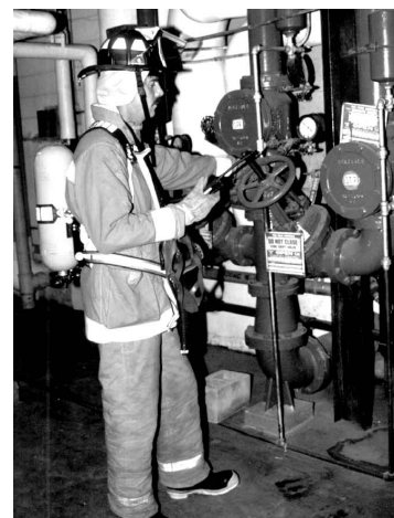
Figura 11.60 Un bombero o un equipo de bomberos, debe verificar visualmente el correcto funcionamiento del control del sistema y del compartimento donde se encuentran las tuberías montantes.
