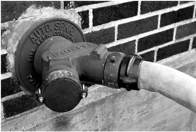
Figura 11.57 Los sistemas de protección contraincendios reciben un bombeo adicional a través de las conexiones del cuerpo de bomberos.
