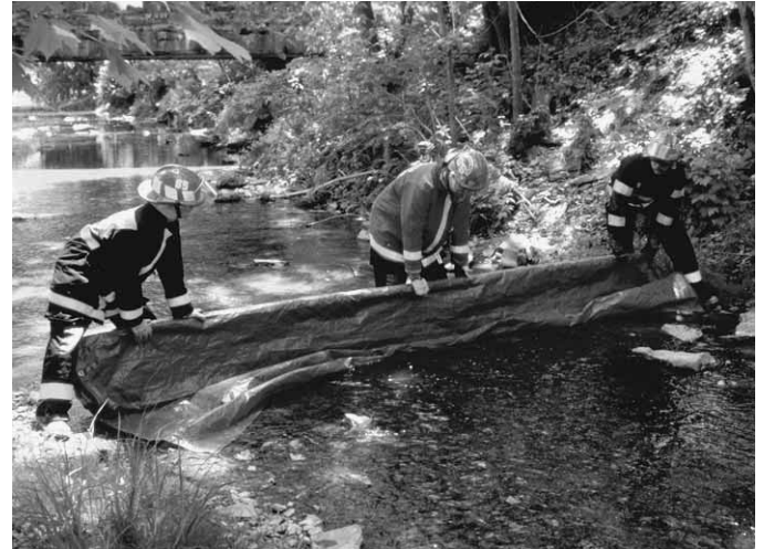
Figura 12.16 Coloque la escala y la lona en la corriente.
