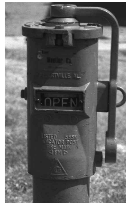
Figura 6.39 La válvula de seguridad muestra el estado de la válvula a través de una ventanilla pequeña.
