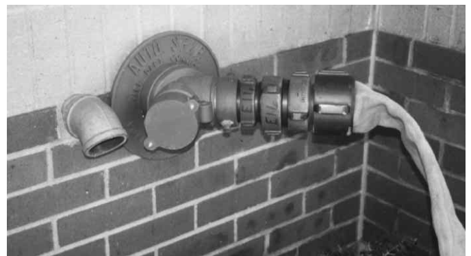
Figura 11.66 Pueden utilizarse un macho doble y una hembra doble para que las conexiones a una junta congelada de la conexión del cuerpo de bomberos sean más fáciles.
