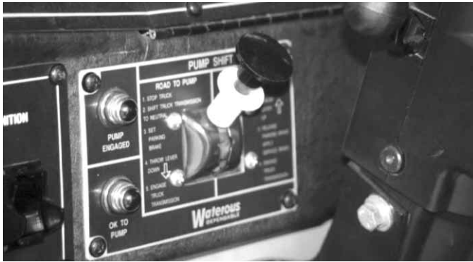
Figure 11.9 Palanca de cambio de una bomba maestra de transferencia.
