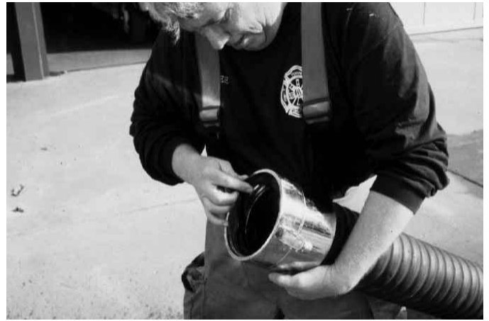
Figura 16.11 Antes de conectar la manguera de toma, inspeccione el estado de las juntas.
