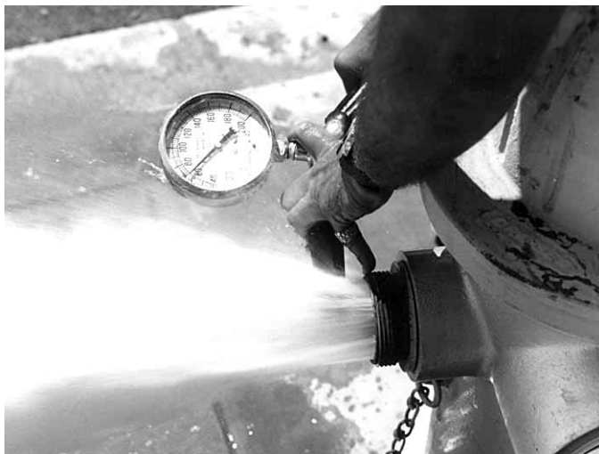
Figura 6.22 La presión del flujo suele medirse insertando un tubo de Pitot y un manómetro en el chorro de un hidrante abierto.
