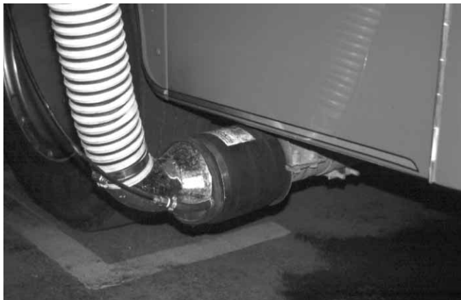
Figura 4.10 Algunos sistemas de escape expulsan automáticamente la manguera del vehículo cuando se mueve del lugar donde estaba aparcado.
