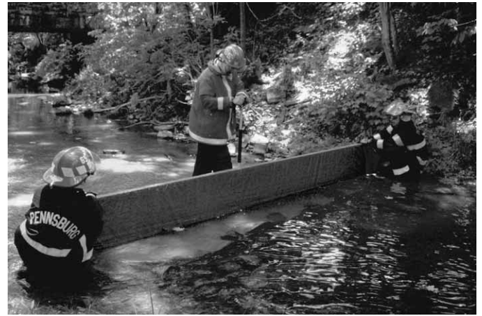
Figura 11.40 En algunos casos, es posible construir un dique en una corriente pequeña para facilitar la succión.
