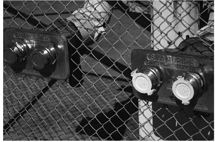
Figura 11.64 Las conexiones del cuerpo de bomberos deben especificar claramente cuál es su uso.
