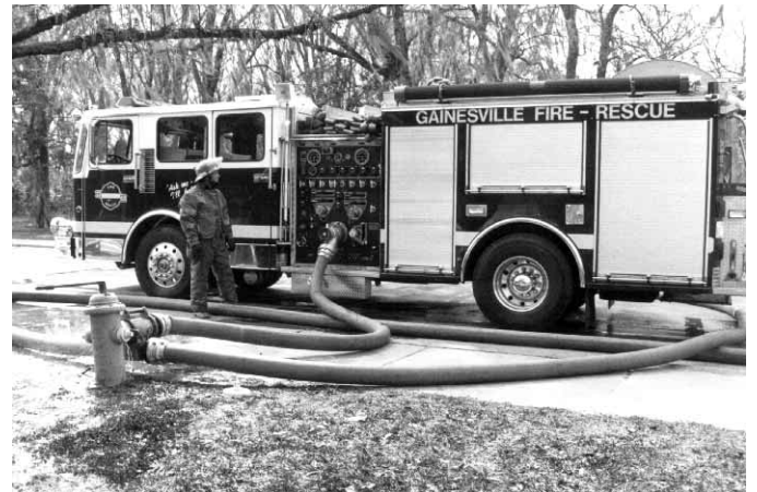
Figura 11.24 El segundo autobomba puede aumentar la presión de la línea de abastecimiento original. Gentileza de Rescate de incendios de Gainesville (Florida, EE.UU.).
