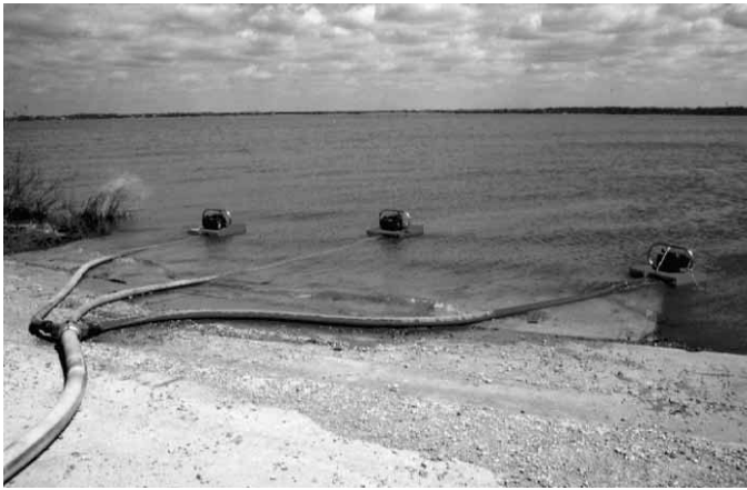
Figura 12.12 En algunos casos, puede que sea necesario utilizar bombas portátiles para bombear el agua de fuentes estáticas que de lo contrario serían inaccesibles.
