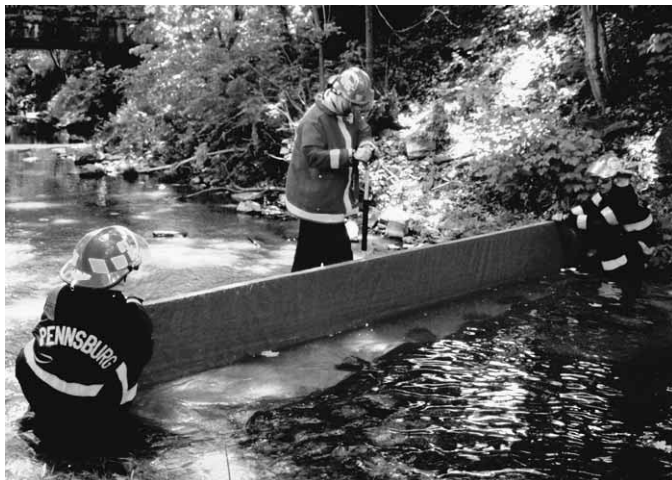
Figura 12.18 Si el agua hace que la escala se curve, coloque algún tipo de soporte detrás del punto medio de la escala.
