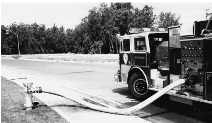
Figura 5.30 Una válvula de compuerta colocada en la descarga de pequeño diámetro permite realizar otra conexión posterior sin tener que interrumpir el flujo de agua que pasa a través de la toma de gran diámetro.
