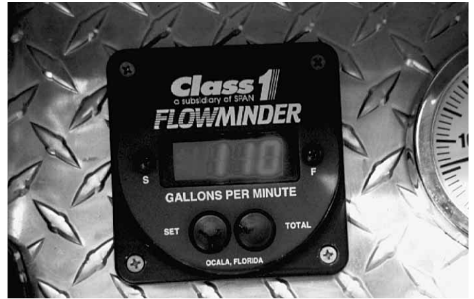
Figura 9.2 Los caudalímetros deben proporcionar una lectura en incrementos de al menos 40 L/min (10 gpm).
